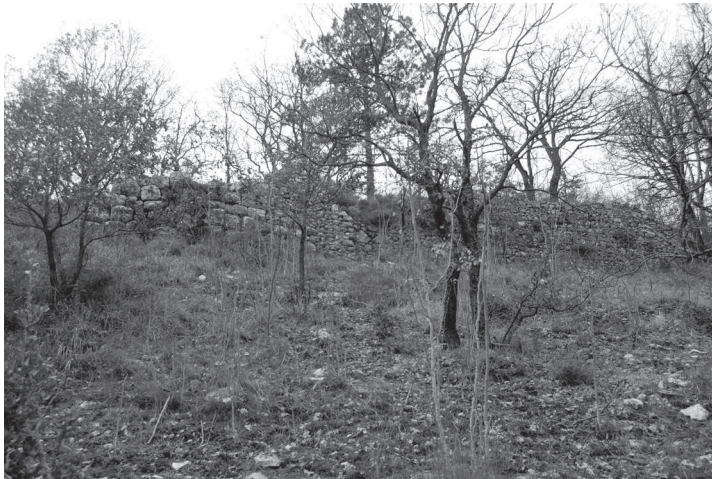
Fig. 6 - Atina-Collina di Santo Stefano, sostruzione in opera poligonale inglobata nelle murature medievali.
